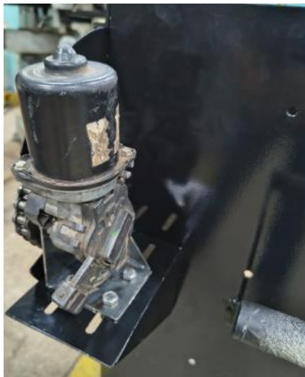
Figura 20 – Instalação do motor elétrico.
