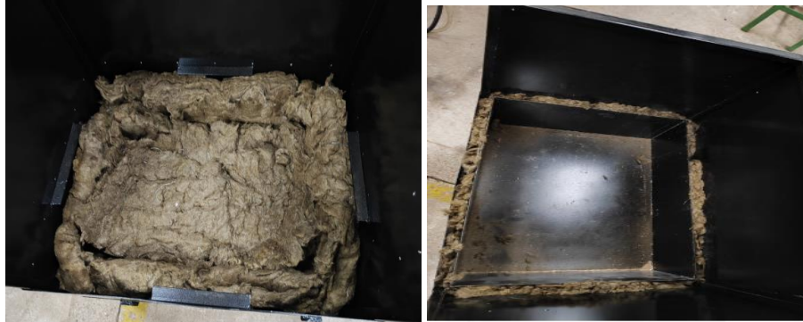
Figura 31 - Montagem da lã de rocha.
