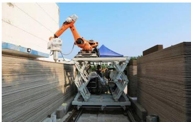
**Figura 9: Impressora de braço robótico**
