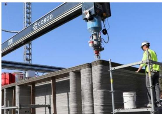
**Figura 3: Impresora depositando concreto**
