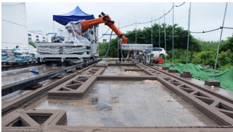
**Figura 5: Levantamento de paredes em conjunto com abertura de vãos**
