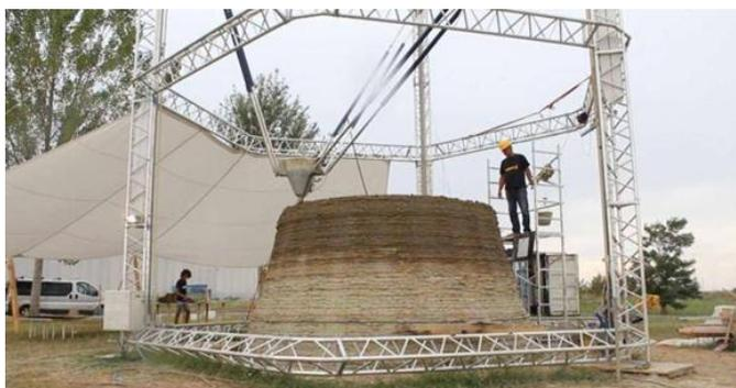
**Figura 11: Máquina de concreto leve**
