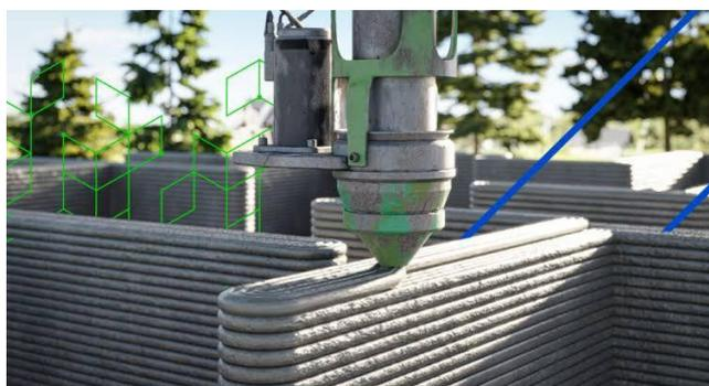
**Figura 4: Levantamento de paredes com movimentos oscilatórios**
