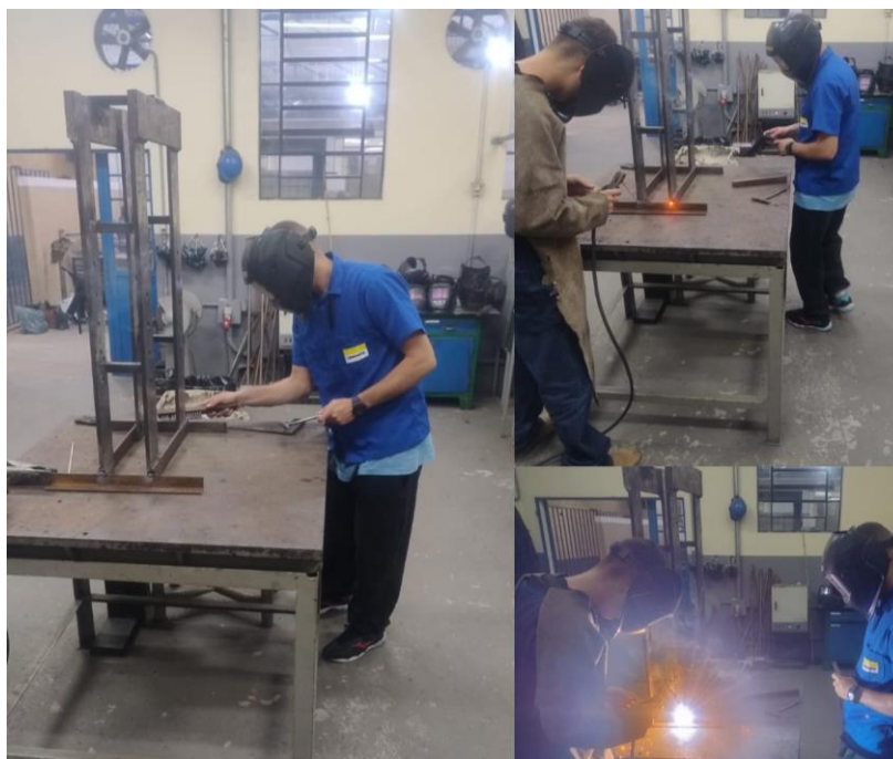
Figura 7 – Solda dos perfis da base.
