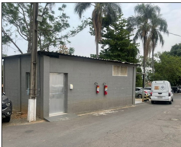
Figura 2: Lateral do abrigo temporário.
