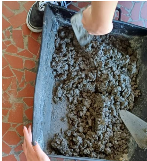
Figura 3 – Maseira com mistura de concreto
