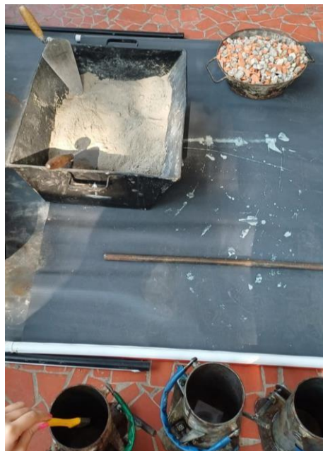
Figura 5 – Mistura do concreto
