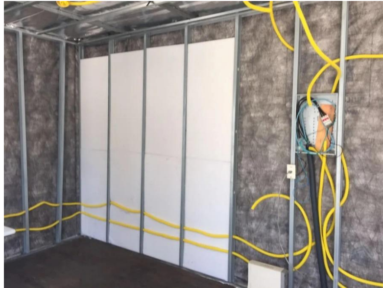
Isolamento Térmico em Container
