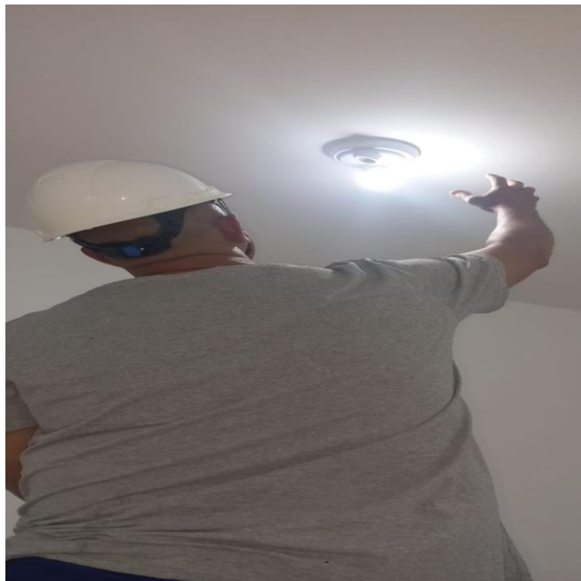
Figura 04 – Verificação da parte elétrica
