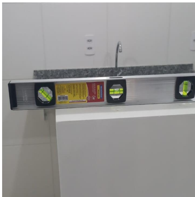
Figura 2- Verificação de nivelamento com nível de bolha em bancada
