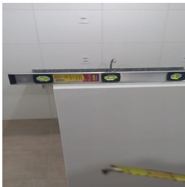
Figura 07 – Nível de bolha para verificação de nivelamento do balcão
