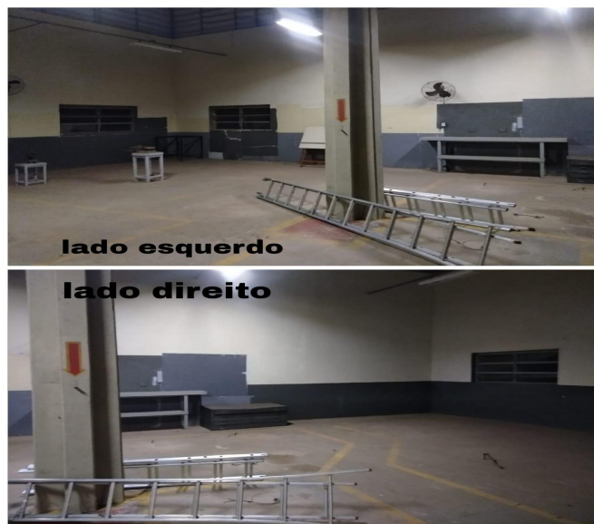
Fotografia 02 - Estado atual da sala de manutenção
