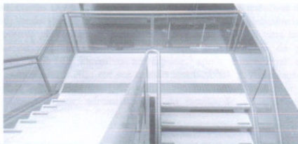
Figura 2 - Piso Tátil na Escada
