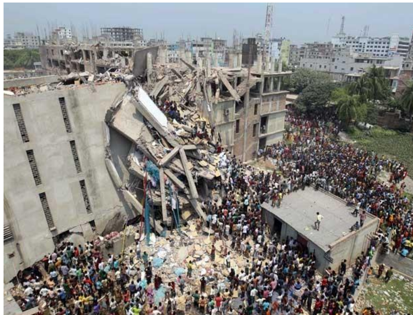
Figura 7 - Escombros Rana Plaza
