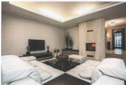
Figura 25 - Forro de drywall
