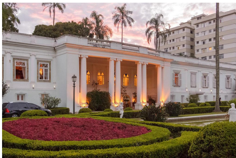
Figura 22 - Hotel Solar do Império
