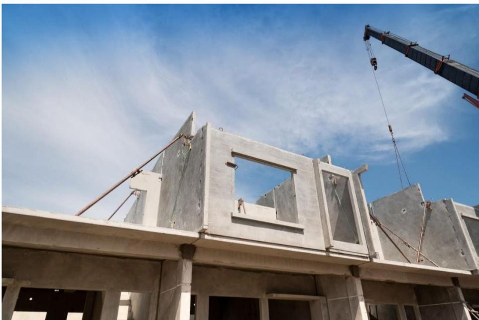
Figura 20: Pré-moldado sendo executado
