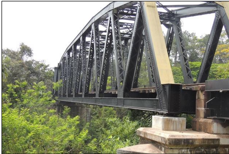
Figura 35- Ponte sobre o Rio Paraíba do Sul
