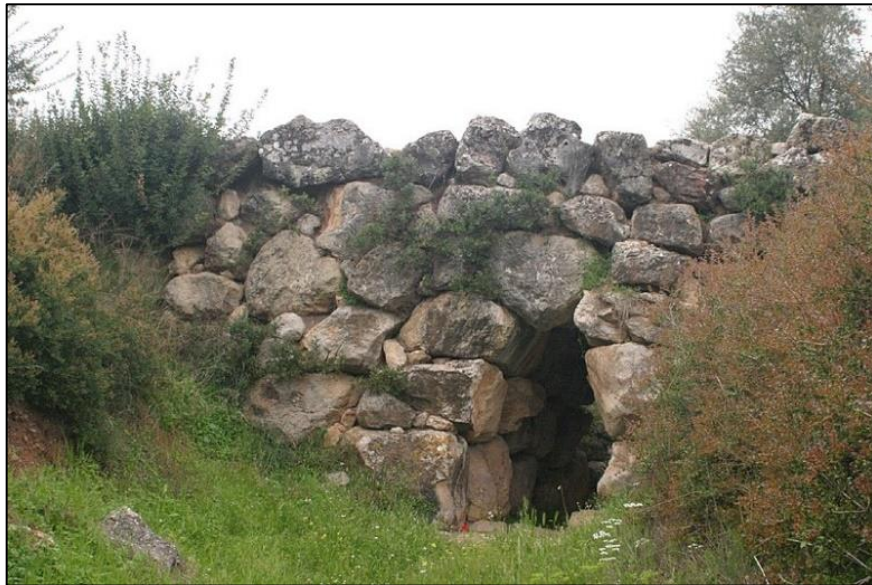
Figura 33- Ponte de Kazarma
