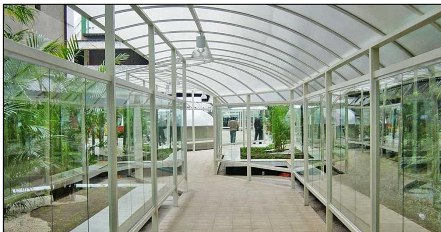
Figura 39 - Passarela com policarbonato no Sírío Libanez
