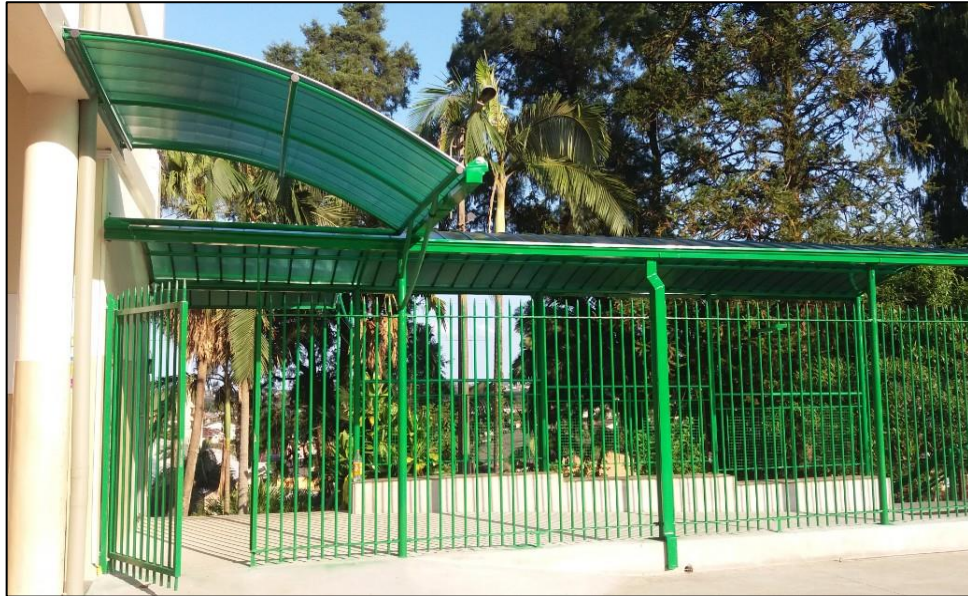
Figura 4- Passarela de metal com cobertura em policarbonato
