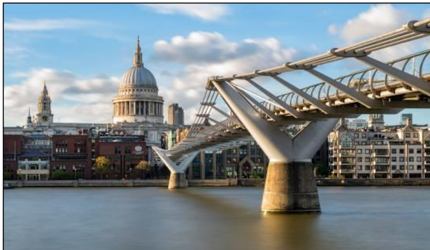
Figura 37- Millennium Bridge, Londres
