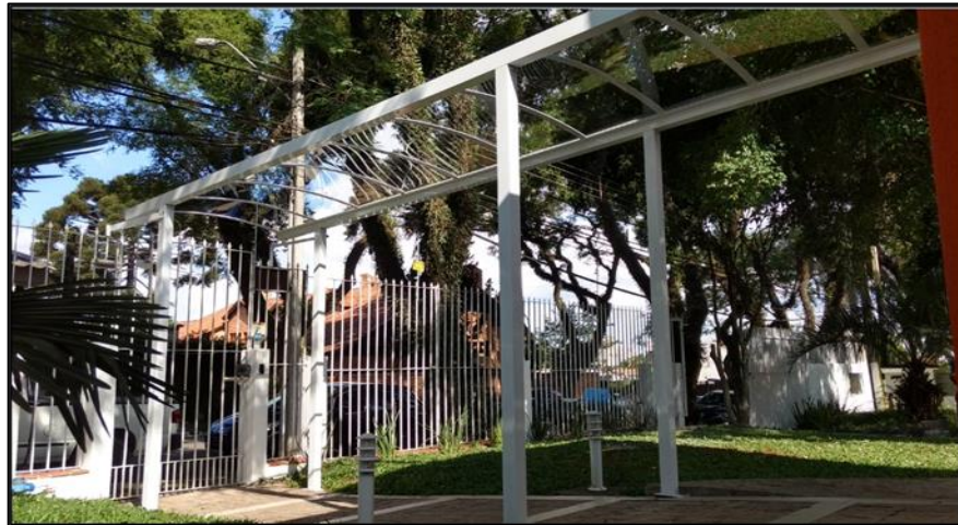
Figura 43- Passarela coberta com estrutura em ferro
