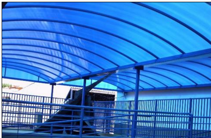
Figura 44- Cobertura policarbonato alveolar
