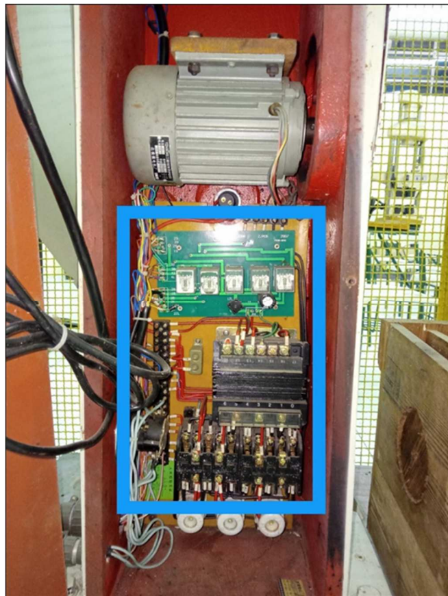
Figura 10: Exemplo de instalação da placa de acrílico
