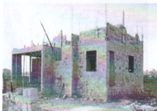
Figura 3: Misto bloco cerâmico e concreto (alvenaria comum)
