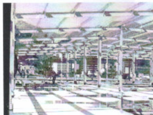
Figura 9. Estrutura metálica (misto)
