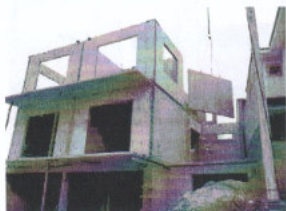
Figura 6. Pré-fabricados de concreto
