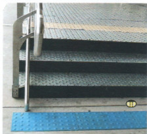
Imagem 34 – Escada com pisos táteis
