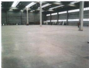
Imagem 32 – Pavimentação em concreto
