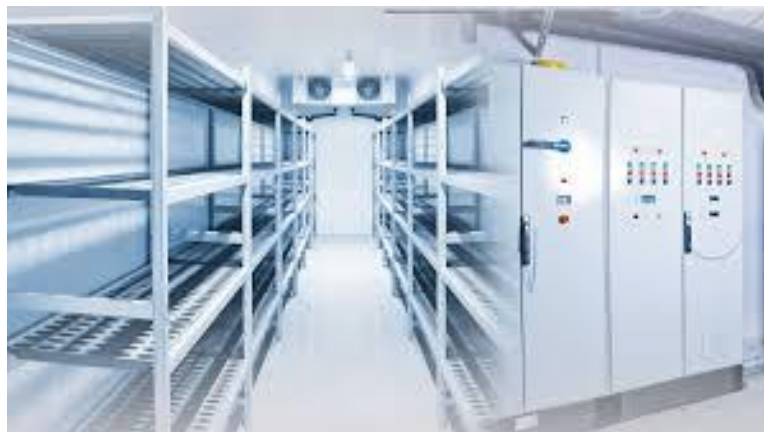
Imagem 13: Frigorífico da cozinha.
