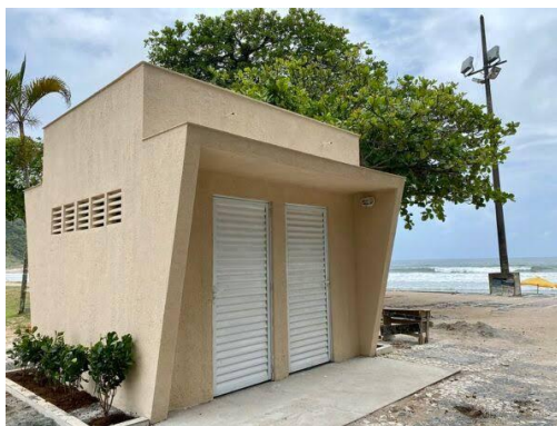
Figura 35 - Banheiro de Guarujá
