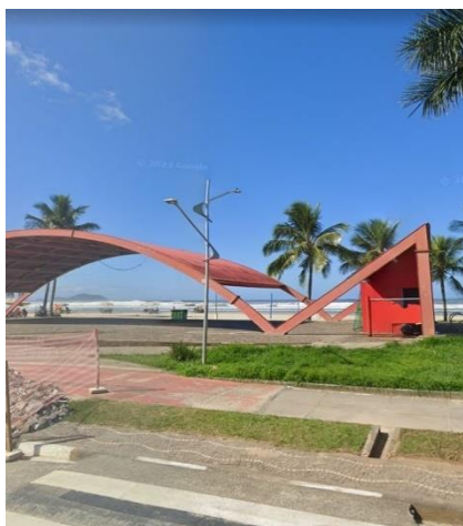
Figura 36 - Banheiro de Bertioga
