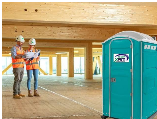
Figura 39 - Problematização dos banheiros provisórios
