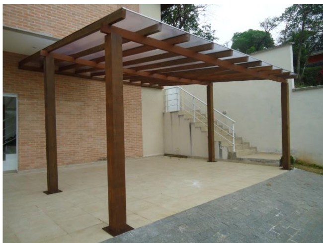
Figura 11: Cobertura de policarbonato em pergolado de madeira.
