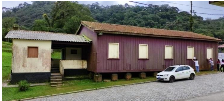
Imagem 3 - Vista Lateral Esquerda
