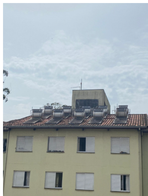
Figura 117: Vista externa da edificação em outro ângulo, que mostra os painéis solares.
