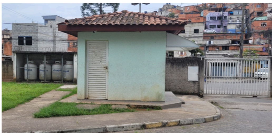
Figura 123: entrada do condomínio e guarita.
