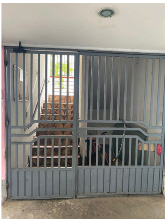
Figura 62: Escada (acesso aos pavimentos superiores) Fonte: do autor
