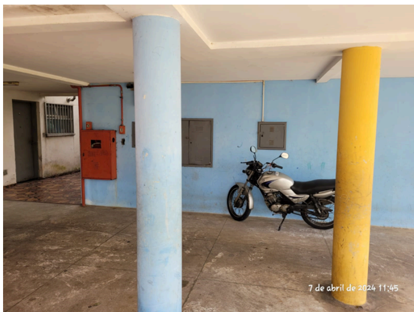
Figura 78: Vista da área externa da edificação
