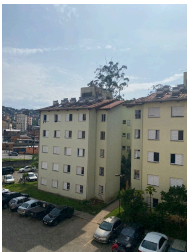
Figura 116: Vista externa da edificação
