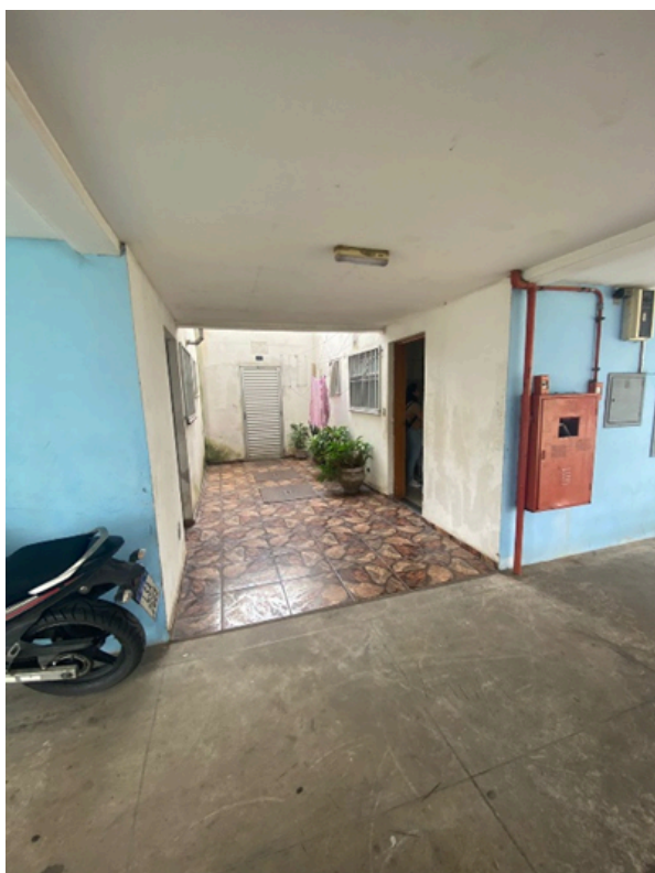
Figura 64: Acesso aos apartamentos do térreo
