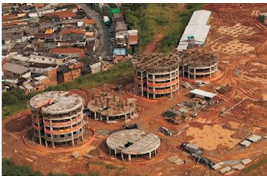
Figura 85: Início das obras
