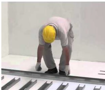
Figura 19: Stick: Também conhecido como “perfil comercial” as peças são vendidas separadamente, cortadas e montadas em obra. Fonte: Google 2024
