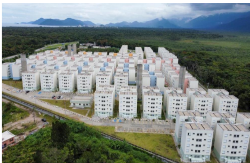
Figura 06: Conjunto habitacional CDHU em São Sebastião
