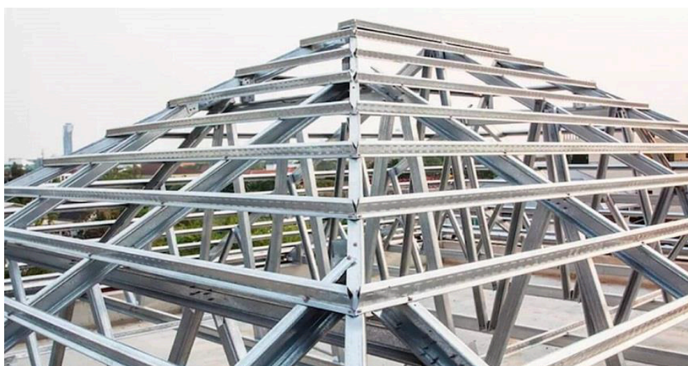
Figura 32: Telhado em Steel frame
