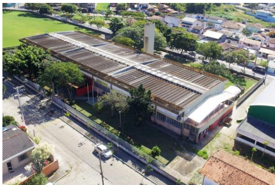
Imagem 2 – Prédio da Etec visto de cima
