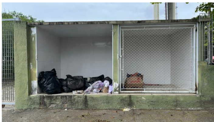
Imagem 6 – imagem do CTR do prédio.
