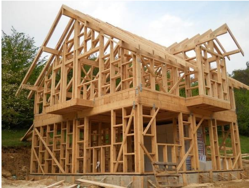
Figura 2 – Construção Modular em Wood Frame .
