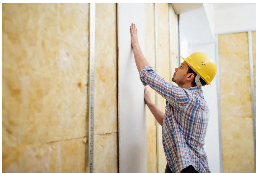
Figura 3 – Placas de Dry Wall sendo instaladas.
