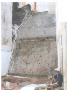
Figura 12: Muro Residencial que Será Transformado em Jardim
