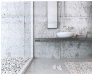
Figura 3: Alvenaria Feita com Placas Pré-Moldadas de Concreto
