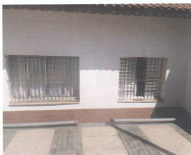
Figura 18: Fachada da Residência
