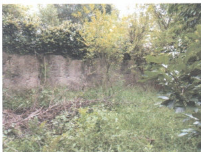
Figura 24: Muro que Cerca o Terreno
