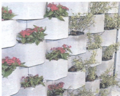
Figura 8: Paredes Verdes Feitas com Blocos de Concreto
