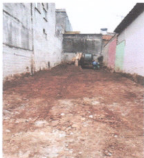
Figura 8 – Terraplanagem do terreno
