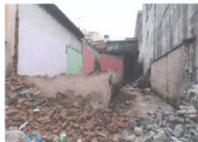
Figura 7 – Demolição parcial da edificação antiga
