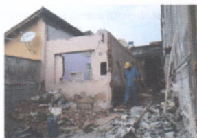
Figura 6 – Demolição da antiga edificação
