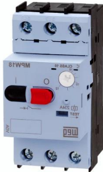
Figura 8: Disjuntor termomagnético
