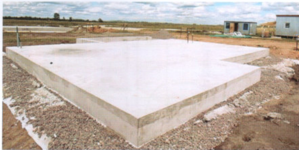
Figura 3: Radier Concretado
