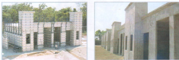
Figura 5: Fôrmas prontas e fôrmas retiradas
