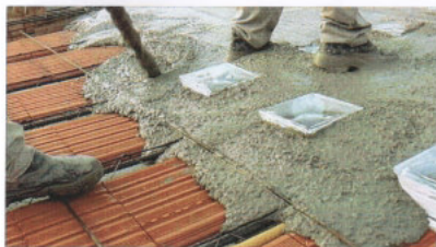
Figura 14: Concretagem da Laje Solar
