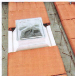
Figura 13: Instalação do bloco de vidro.
