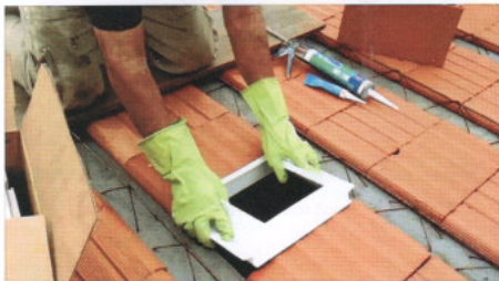
Figura 12: Instalação do Suporte no lugar da Lajota.
