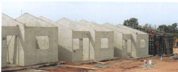
Figura 1: Casas de parede de concreto moldadas In Loco
