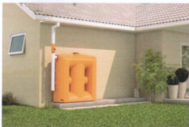
Figura 15: Exemplo de captação com uma cisterna
