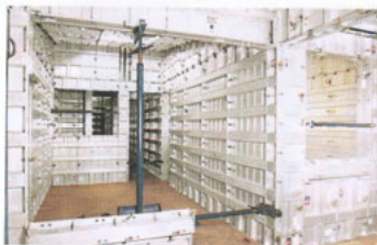
Figura 8: Exemplo de tensores nos vãos
