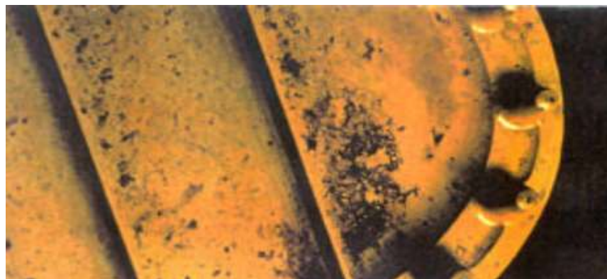
Figura 3. Tanque de combustível corroído.
