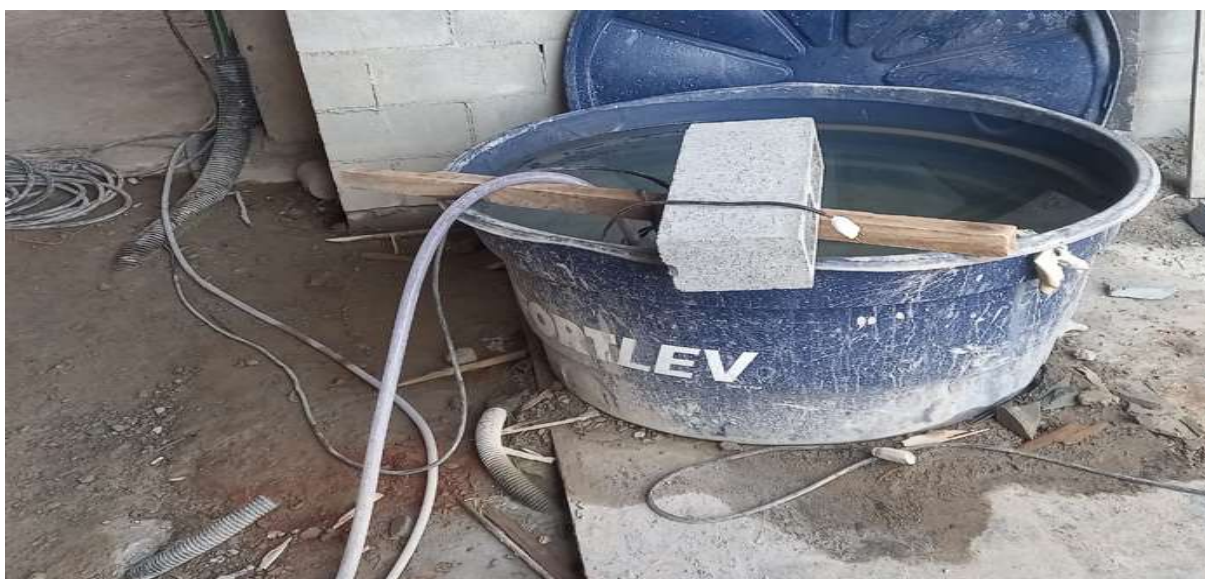
Figura 4: risco de acidente
