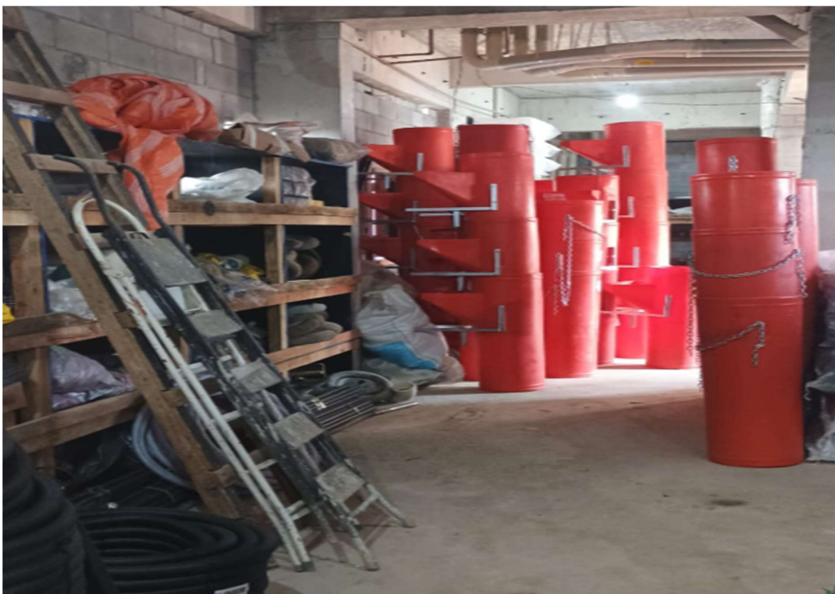
Figura 3: risco de acidentes
