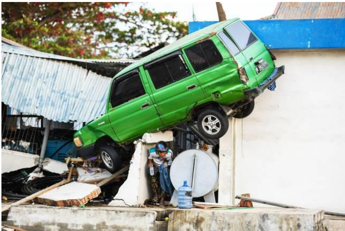
Figura 6 – Destruição e Sobrevivência.
