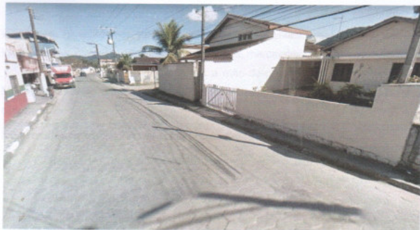
Figura 2: rua com paralelepípedos
