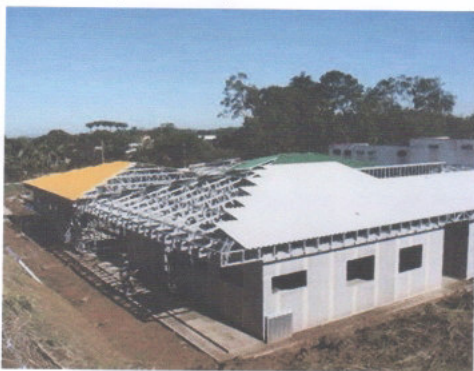
Figura 3 - Cobertura do Light Steel Framing
