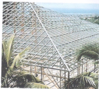
Figura 7 - Armação da cobertura em Light Steel Framing
