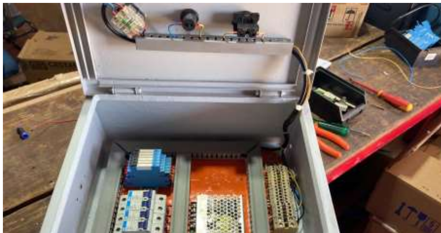
Figura 12: Primeira Montagem dos Botões do Painel FONTE: Arquivo Pessoal (2023).
