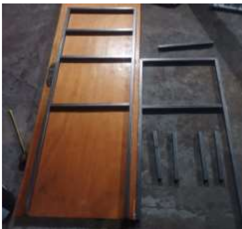
Figura 5: Metalon antes da Soldagem FONTE: Arquivo Pessoal (2023).
