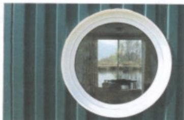
Janela em perfil metálico raio 40x40
