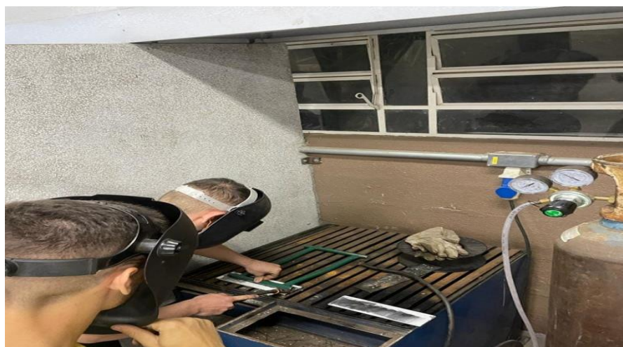
Figura 9 – Processo de soldagem
