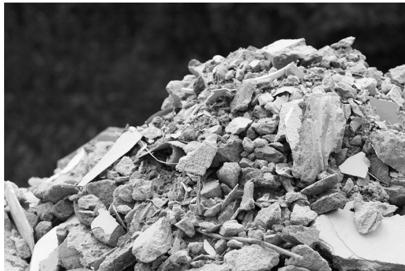
Figura 1 – Resíduos de Construção Civil e Demolição
