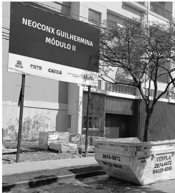
Foto 2 – Caçambas de Entulho – Conx Construtora
