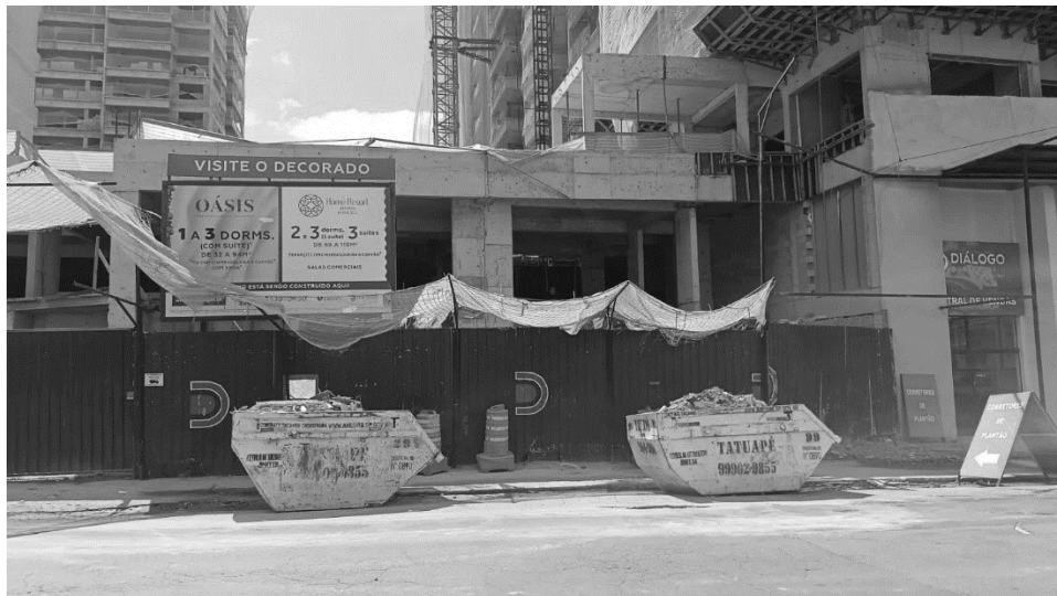
Foto 1 – Caçambas de Entulho – Diálogo Engenharia
