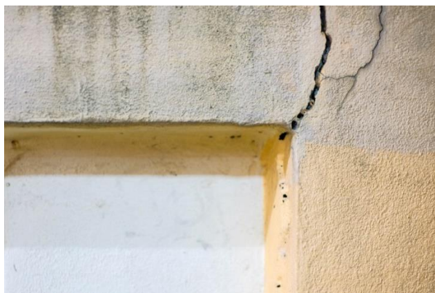
Figura 2- Rachadura Profunda
