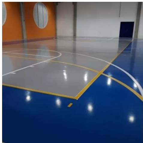
Figura 9: Tinta Epóxi aplicada em chão de quadra // Fonte: Mercado Livre.
