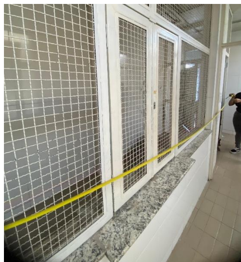
Figura 6: Trena sendo aplicada em vestiário da quadra (adaptado pelo autor).
