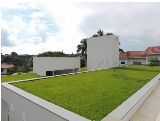
Figura 18 - Telhado verde extensivo, fonte: extensivo
