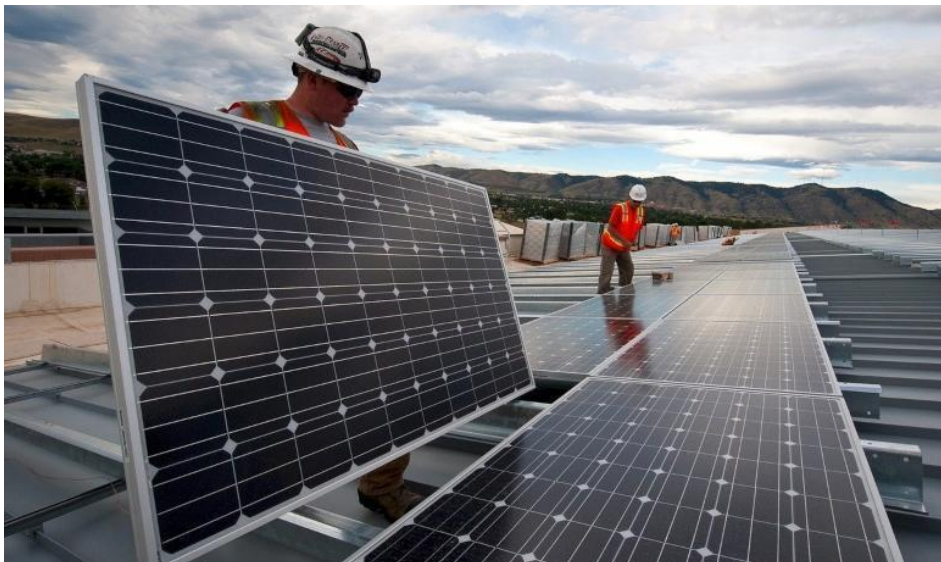
Foto 3 - Aplicação de placas solares
