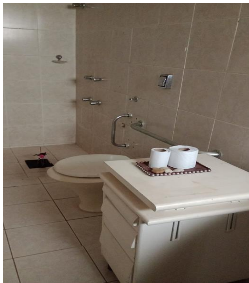
Figura 5. Sanitário para uso de acessibilidade.
