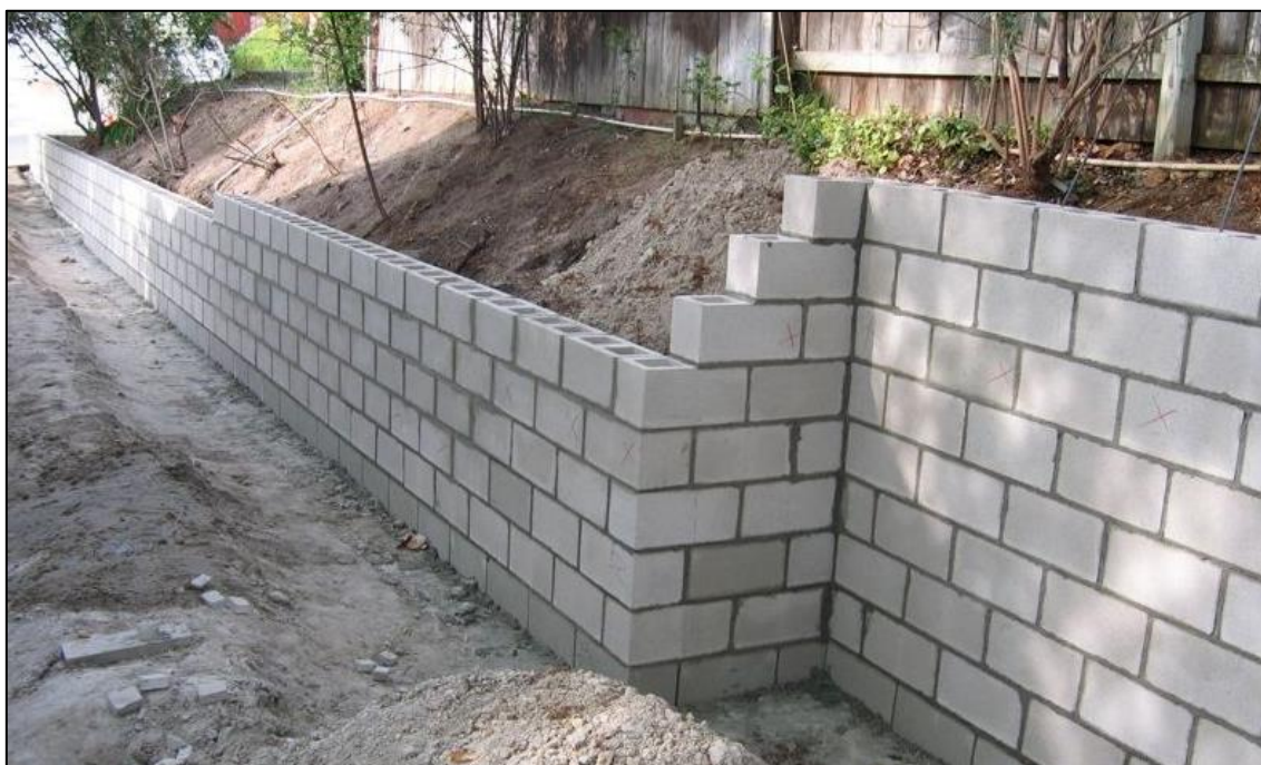
Figura 15 – Muro com bloco estrutural
