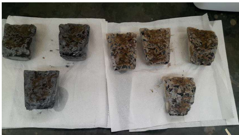
Imagem 26: Concreto após a aplicação do \text{AgNO}_3
