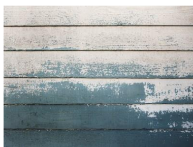
Figura 9 - Desbotamento
