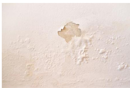
Figura 10 - Bolhas na pintura.
