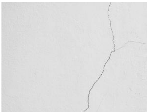
Figura 1 - Fissuras na alvenaria
