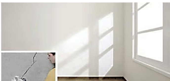
Figura 38 - Restauração das rachaduras na parede.
