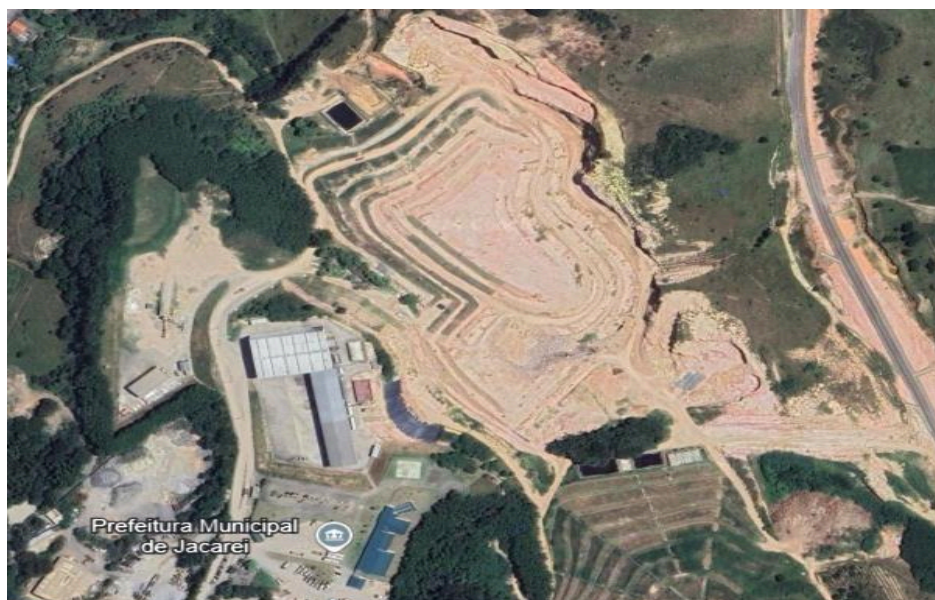
Figura 8: Aterro sanitário de Jacareí
