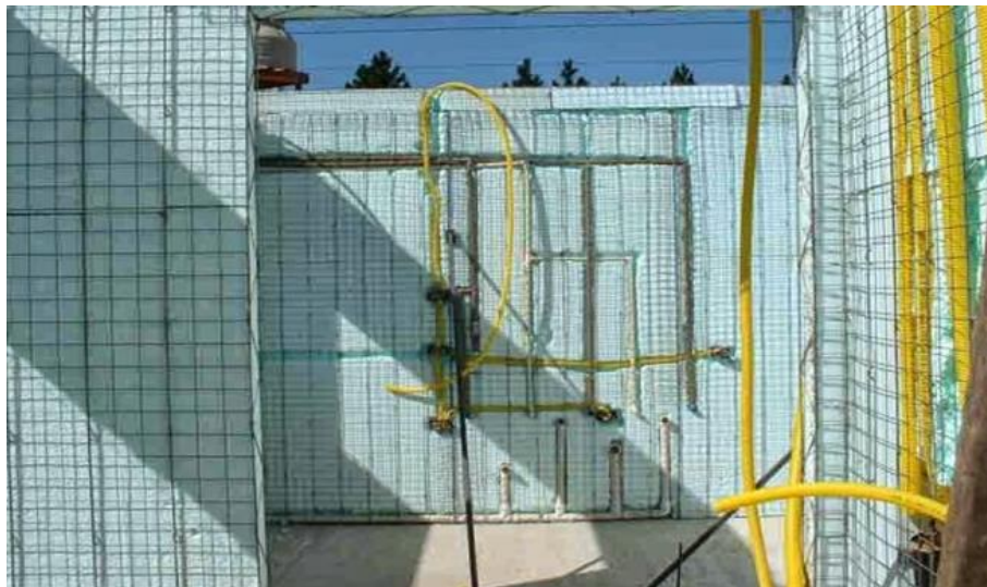
Figura 12: Instalação das tubulações
