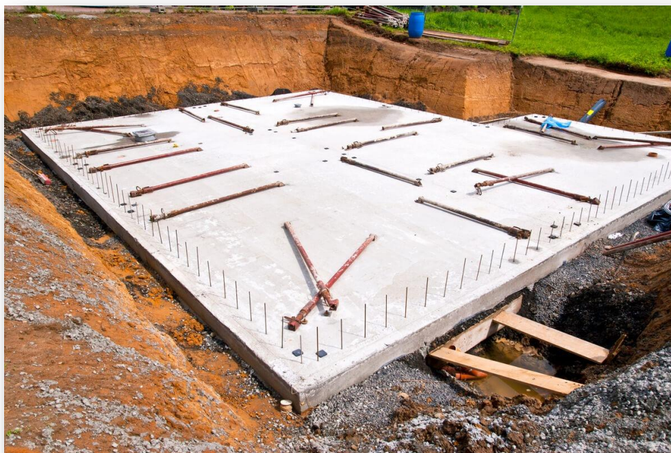
Figura 8: Barras de fixação posicionadas
