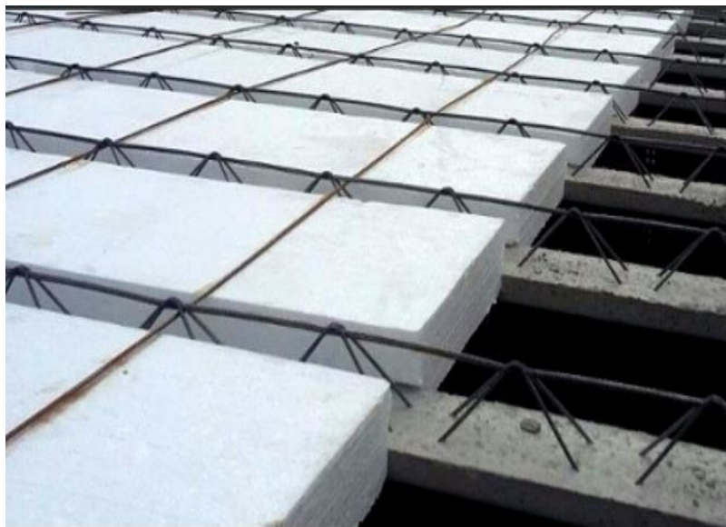
Figura 15: laje com EPS
