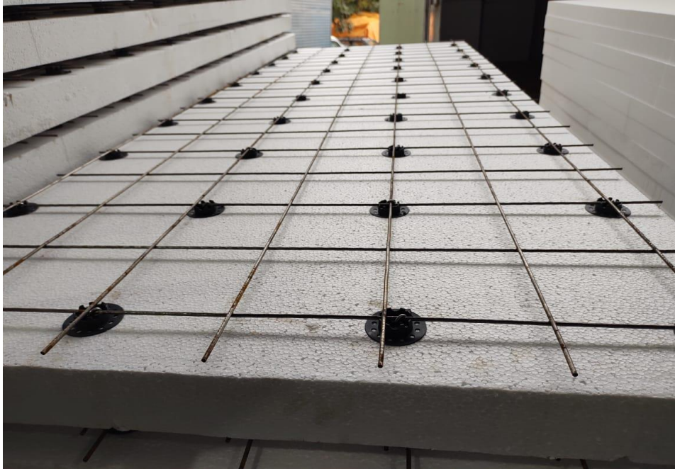
Figura 04: Painel com Espaçadores posicionados
