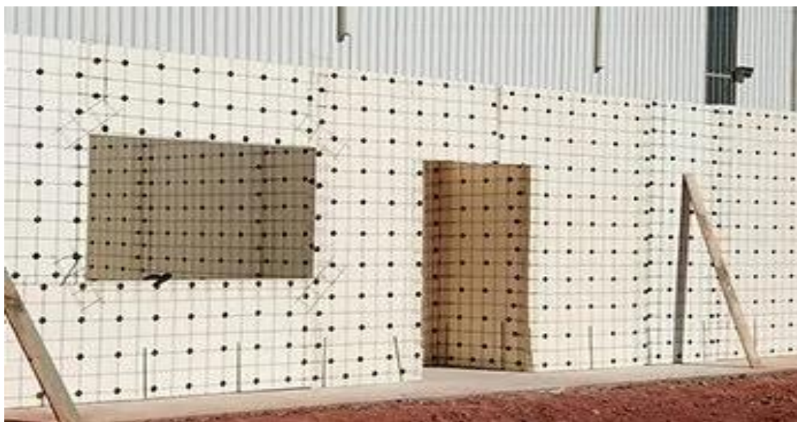
Figura 11: Abertura dos vãos
