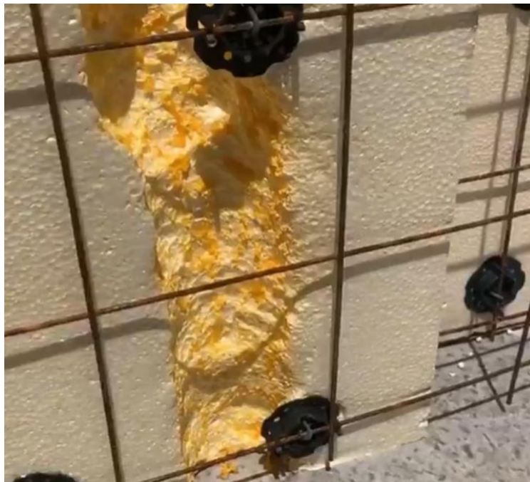
Figura 13: Marcação dos traços com soprador
