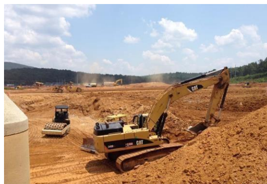
Figura xxx: Unidade escavadeira terraplanagem
