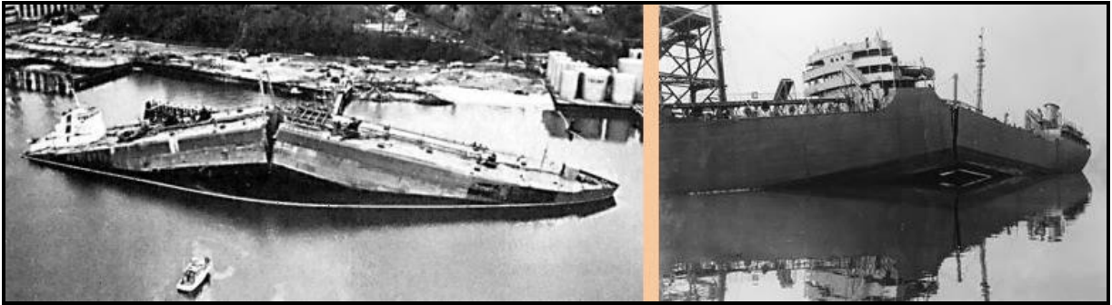
Figura 10: Fratura frágil em navios Liberty ainda no porto.
