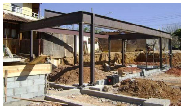
Figura 39 - Salão de Jogo em Estrutura Metálica
