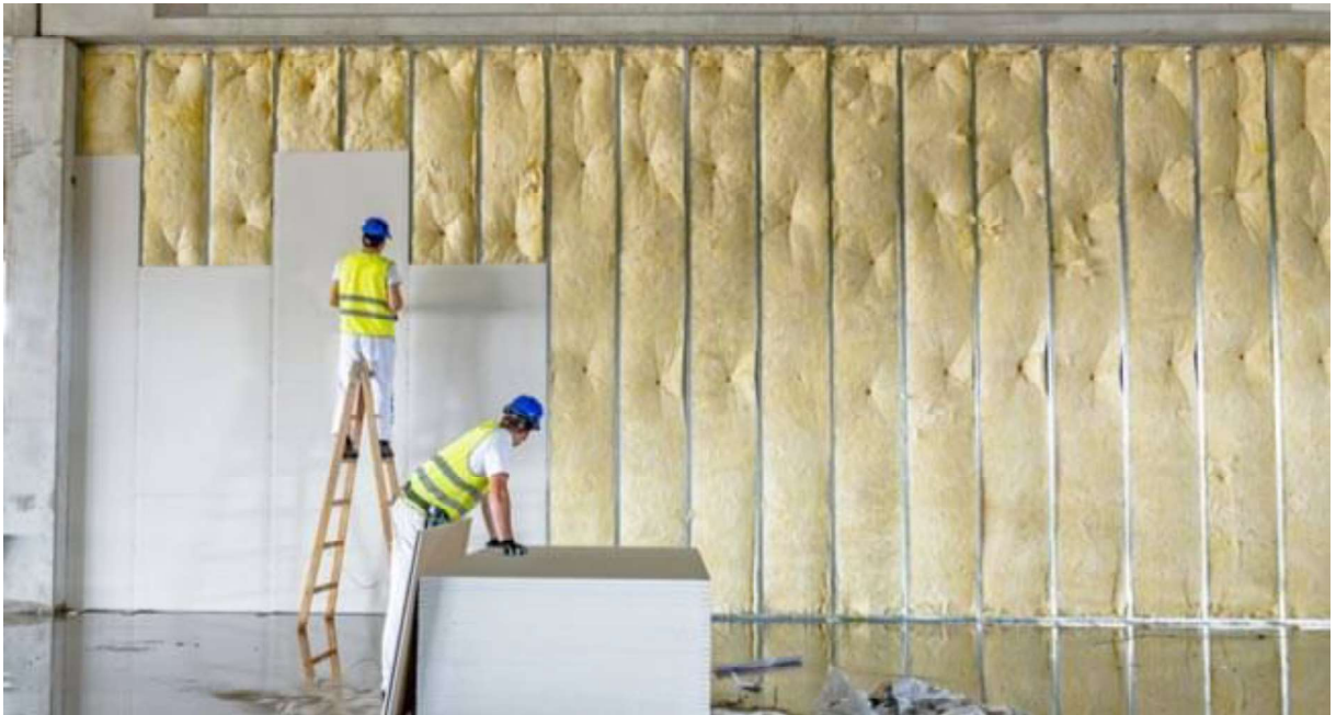
Figura 6 - Drywall com isolamento termoacústico
